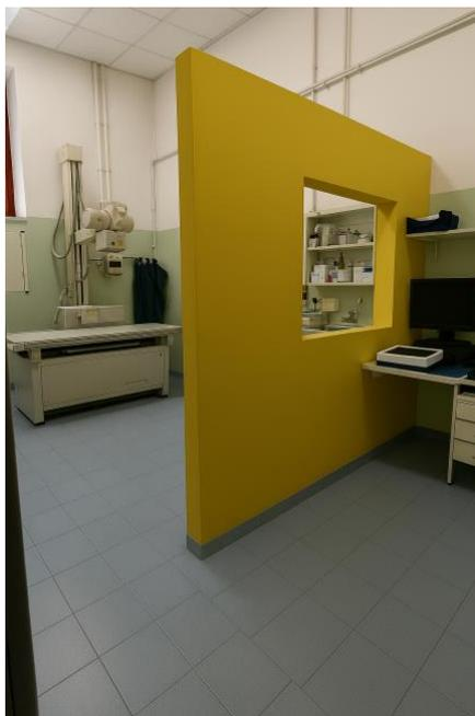
*Figura 58. Schermatura di piombo in muratura e vetro piombato presente all'interno della sala radiologica PA.*
